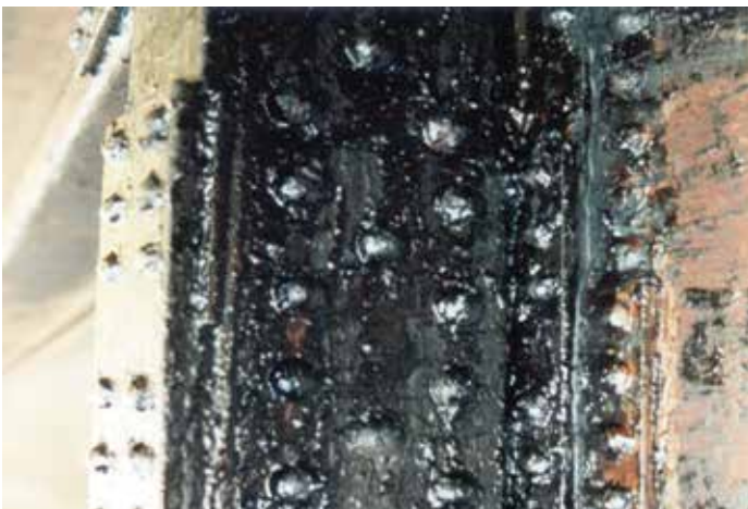
Beseitigung von verhartetem Öl zu Renovierungszwecken | vor der Reinigung
