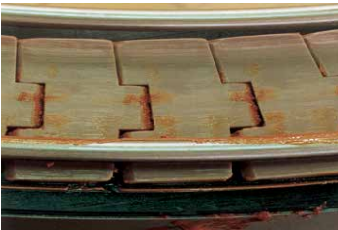
Reinigung von Förderbändern | vor der Reinigung
