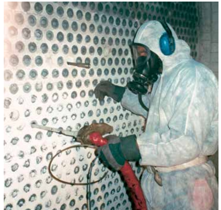
In manchen Fällen sind Atemschutzmasken dringend zu empfehlen – zB wenn Wärmetauscher gereinigt und schädliche Materialien abgestrahlt werden.
