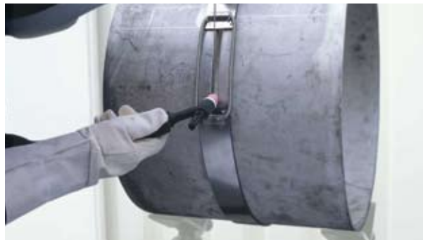
Abdichten des Schweißstoßes während des Schweißens, Bild: Jankus
